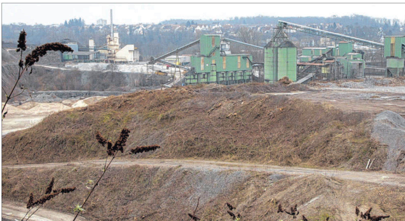
Blick in den Steinbruch Fink, der als Steinbruch ausgedient hat. Ein Betreiberkonsortium will auf dem Nutzgelände eine Biomüllvergärungsanlage errichten. Doch dagegen regt sich Widerstand. Laut einer BZ-Umfrage halten sich Befürworter und Gegner in etwa die Waage – noch. Foto: Helmut Pangerl
