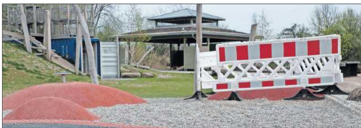
Hopp-Anlage: oben 2017 Trubel am Eröffnungstag, unten Sperrung 2018, da sich Belag löst. FOTO: LENZ ARCHIV, YVV
